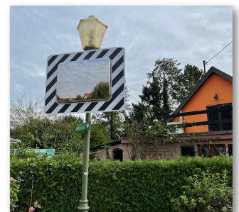
Remplacement du miroir routier rue Longue
